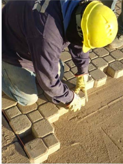
Lo anterior equivale a colocarlos a tope, sin dejar, a propósito, una junta abierta. Por las irregularidades de los adoquines y de la colocación, se genera una junta que, en promedio, debe tener 2,5 mm y que nunca debe ser mayor a 5 mm (medio centímetro), en cuyo caso se debe cerrar con la ayuda de un martillo de caucho.
