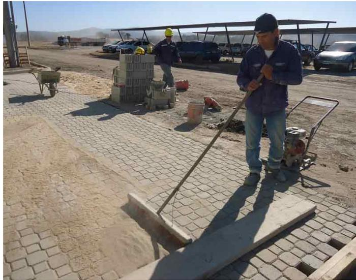
Una vez completado éste procedimiento, se realizará una **nueva compactación final** del pavimento de adoquines.
