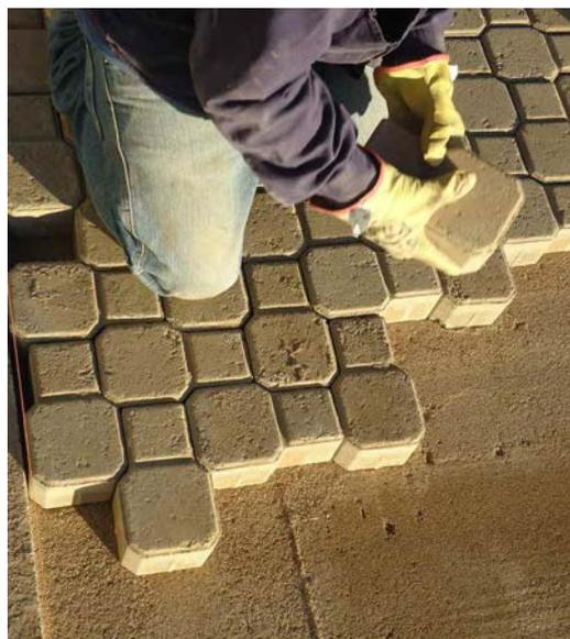
No es necesario ajustar los adoquines verticalmente, con golpes; pero se recomienda ajustarlos horizontalmente con un martillo de caucho, cuando sea necesario cerrar un poco la junta o conservar el alineamiento horizontal. En calles con pendiente bien definida, es aconsejable colocar los adoquines de abajo hacia arriba.
